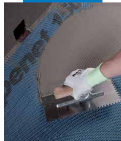
Mapelastic felhordása Mapienet 150-re
