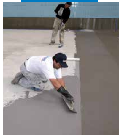
Úszómedence vízszigetelése Mapelastic-kal
