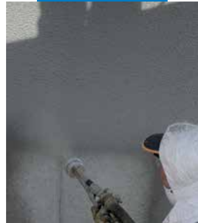
Példa Mapelastic szórásos felhordására viadukton
