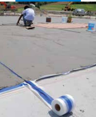
Esztrichek vízszigetelése Mapelastic-kal és Mapeband-dal
