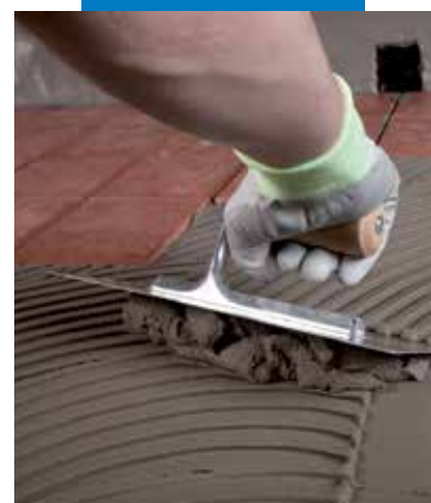
Granirapid felhordása Mapelastic-kal vízszigetelt teraszra
