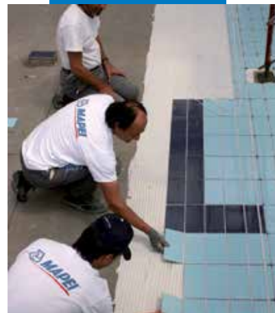
Kerámia burkolólapok fektetése Mapelastic-ra úszómedencében
