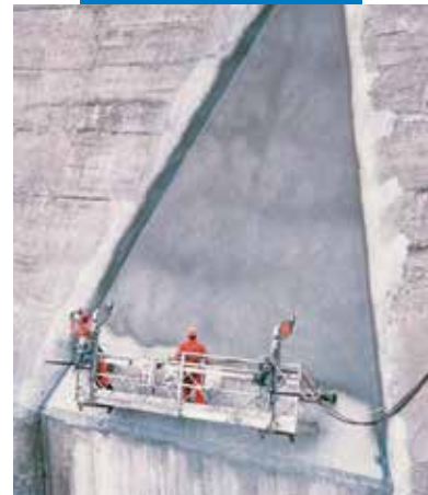
Példa Mapelastic szórásos felhordására gátra
