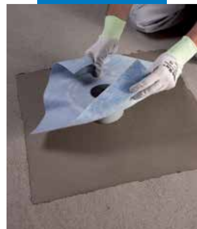
Drain Vertical beépítése Mapelastic-ra
