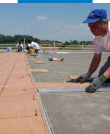
Kerámia burkolólapok fektetése Kerabond + Isolastic keverékkel
